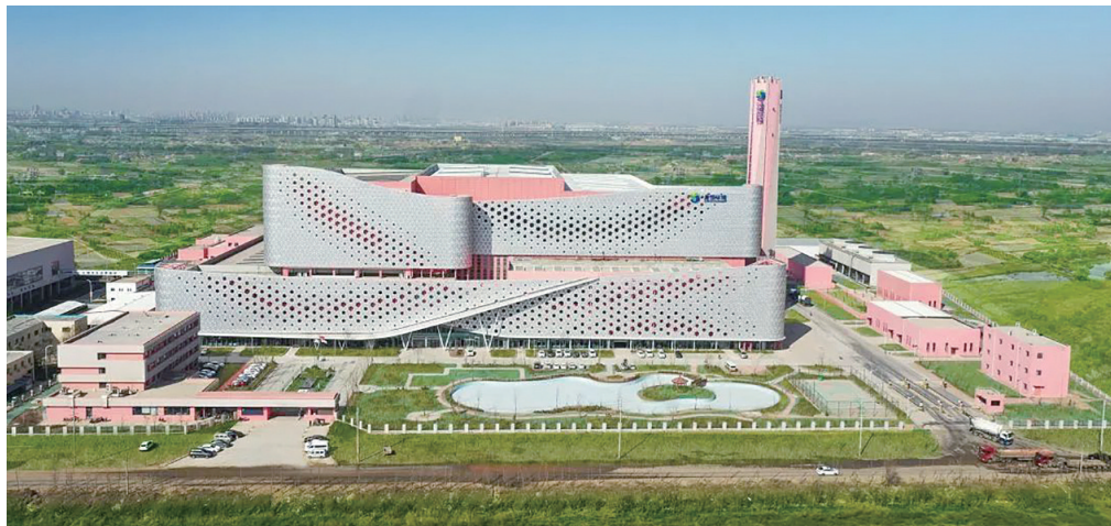
小涧西生活垃圾焚烧厂二期。
