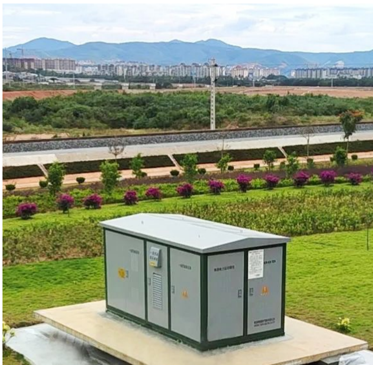
特锐德为雅万高铁全线提供铁路电力远动箱式变电站。
