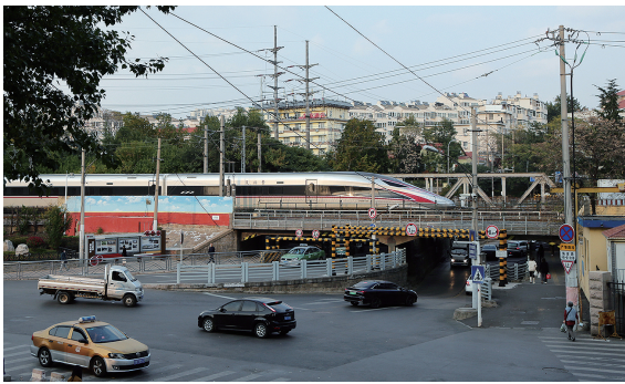
海岸路铁路桥是目前山东省境内服役年限最长的铁路钢梁桥。 徐常青 摄
