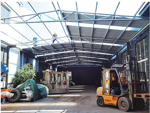
工人们拆除厂房的房顶。 刘卓毅 摄
