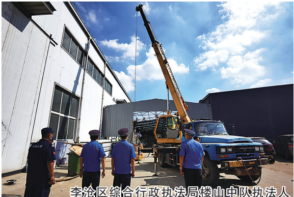
李沧区综合行政执法局楼山中队执法人员组织拆除违法建设的厂房。 刘卓毅 摄
