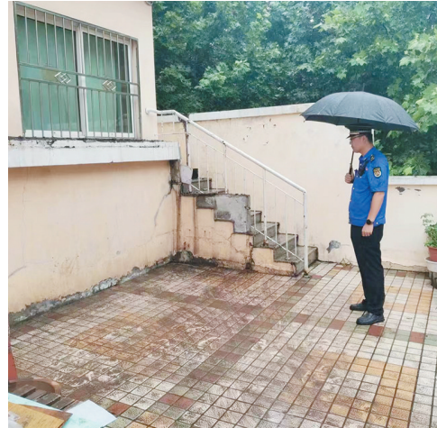
李沧区综合行政执法局振华路中队执法人员在现场部署拆除行动。
