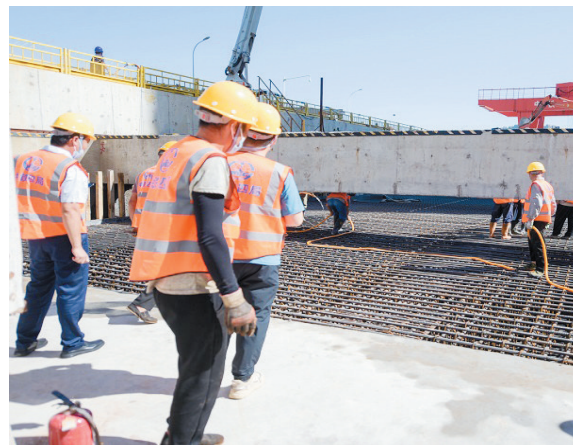
参建人员全力以赴推进地铁建设。
