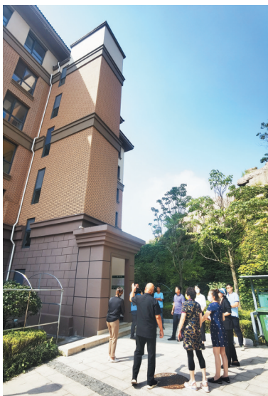
大家在参观上流家园小区里新加装的电梯。
