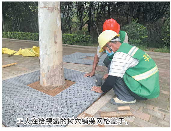
工人在给裸露的树穴铺装网格盖子。 石颗粒、选用新型材质树穴算子等多种方式对树穴进行改造提升。”李沧园林相关负责人介绍,他们将通过因地制宜的整治方式逐步提高道路树穴景观,使原有绿化提档升级。
