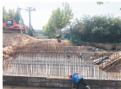
西海岸新区为水毁路桥“疗伤”。
