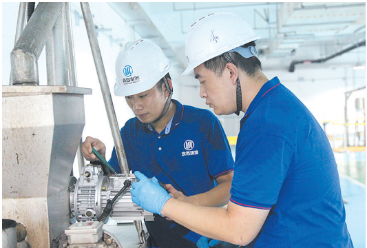
青岛水务张村河水务员工在全地下车间维修除臭加药电机。任芯慧 摄
