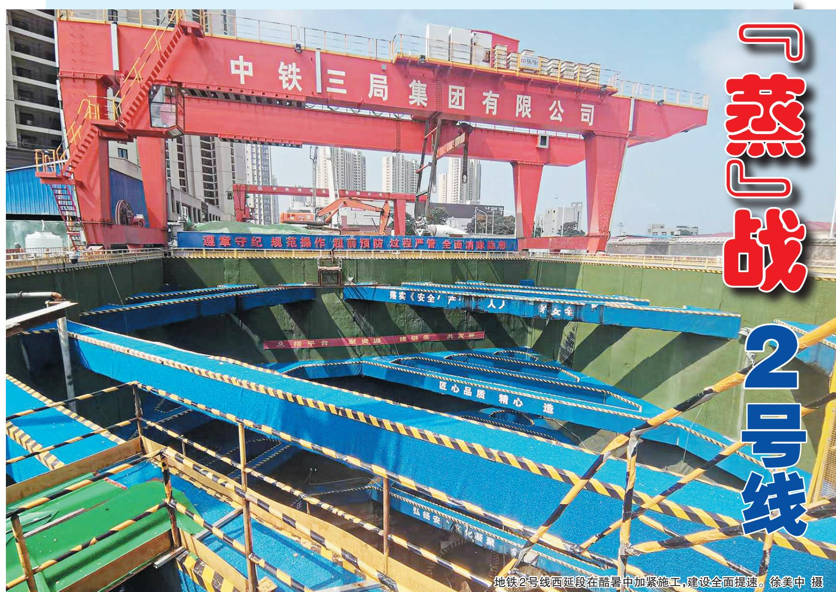
为地铁2号线西延段早日贯通,工人们在地下30余米处“蒸桑拿”奋战。3日,记者来到地铁2号线西延段最长区间隧道——轮渡站至小港站区间探访发现,建设者正加紧进行左线TBM施工,推动项目建设全面提速。该线路计划2024年底完工,开通后将极大方便西部城区金茂湾、晓港名城等小区居民出行,更好地支撑国际邮轮港区开发建设。
