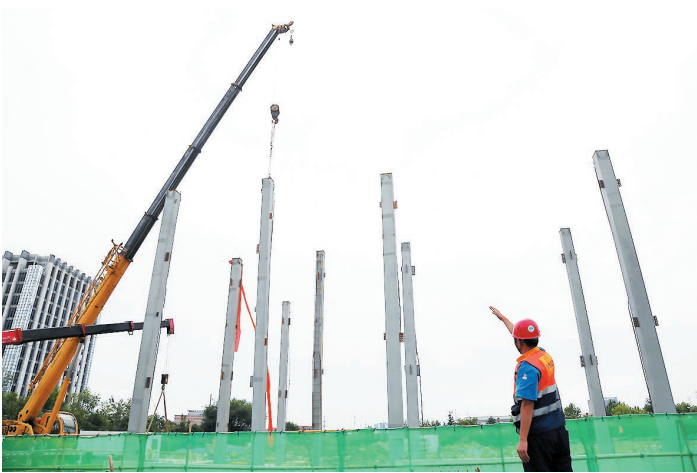
目前1号厂房已安装了9根钢桩。
