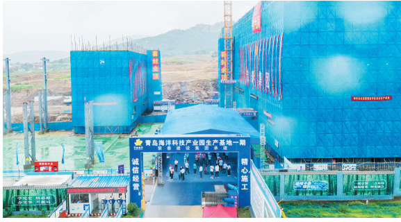
国内首条液体火箭低温推进剂铝合金贮箱HOETS产线项目主体封顶。
