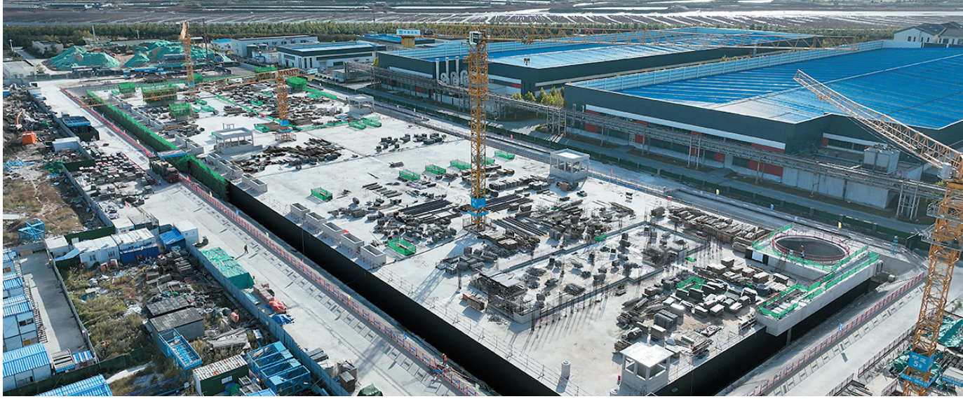
■上合示范区污水处理厂迁(扩)建项目施工现场。
