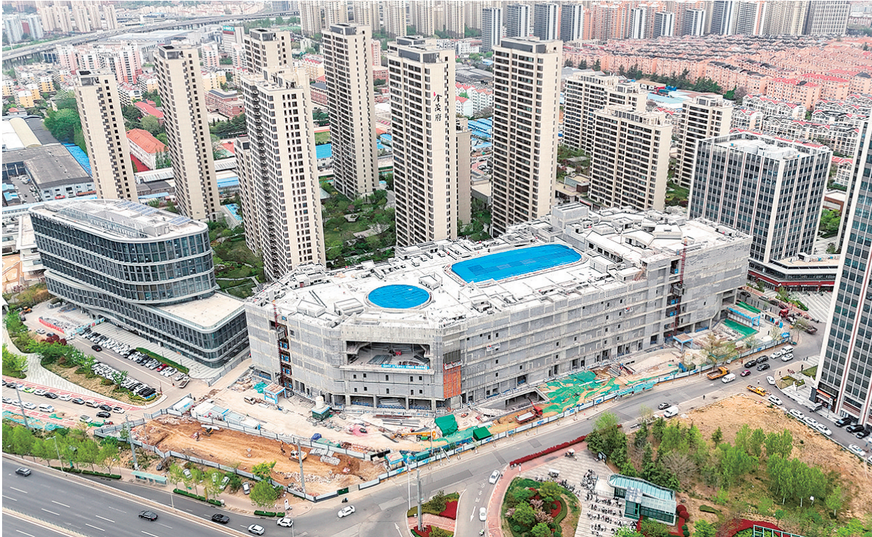
■李沧吾悦广场正在加速推进各项工程建设。
