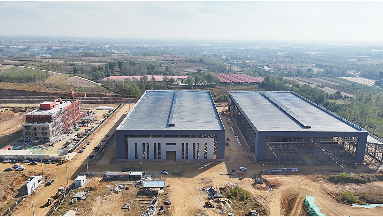
芯源锂电池负极材料项目已经实现主体完工。
