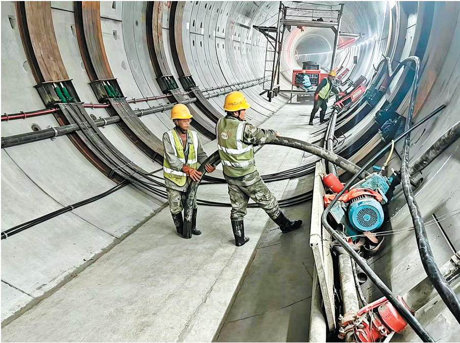
■地铁9号线西荆站有序推进联络通道与车站收尾关键工序。周建亮 摄
