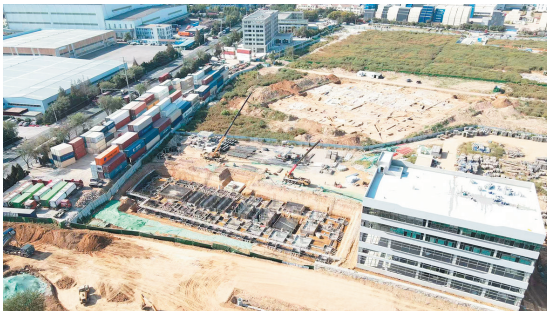
青岛（自贸区）万洋科技城项目建设现场。
