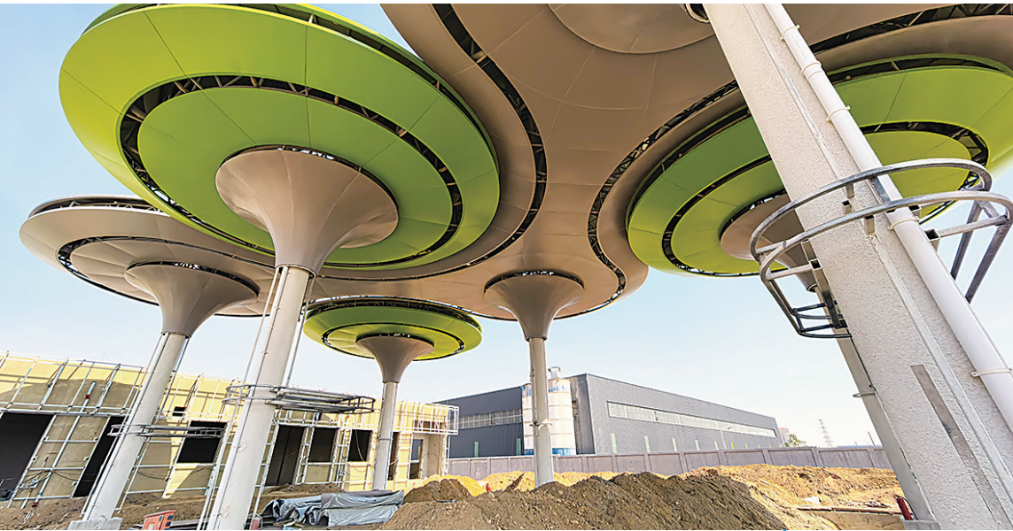
■青岛市氢能产业园加氢站加氢罩棚已完成95%左右。 王 凯 摄
