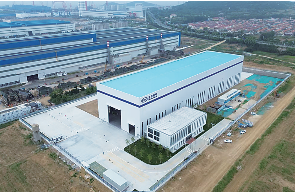
■东方电气(青岛)海上风电产业基地一期项目鸟瞰。
