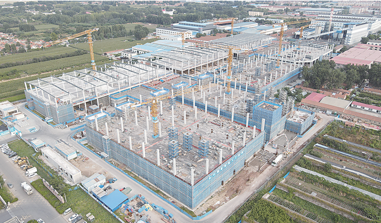
■中棉上合棉花数智物资产业园项目施工现场俯瞰。
