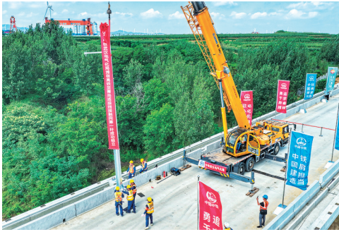
■潍宿高铁至青岛连接线立起“四电”接触网工程第一杆。
