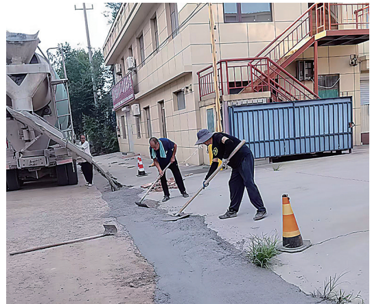
■管道改造施工现场。
