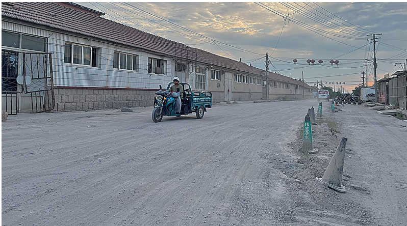
■村民反映的“搓板路”已用石渣铺平,路况得到改善。
