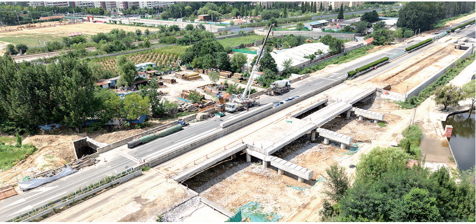
■荣潍高速公路莱阳至潍坊段改扩建工程平度段施工现场。
