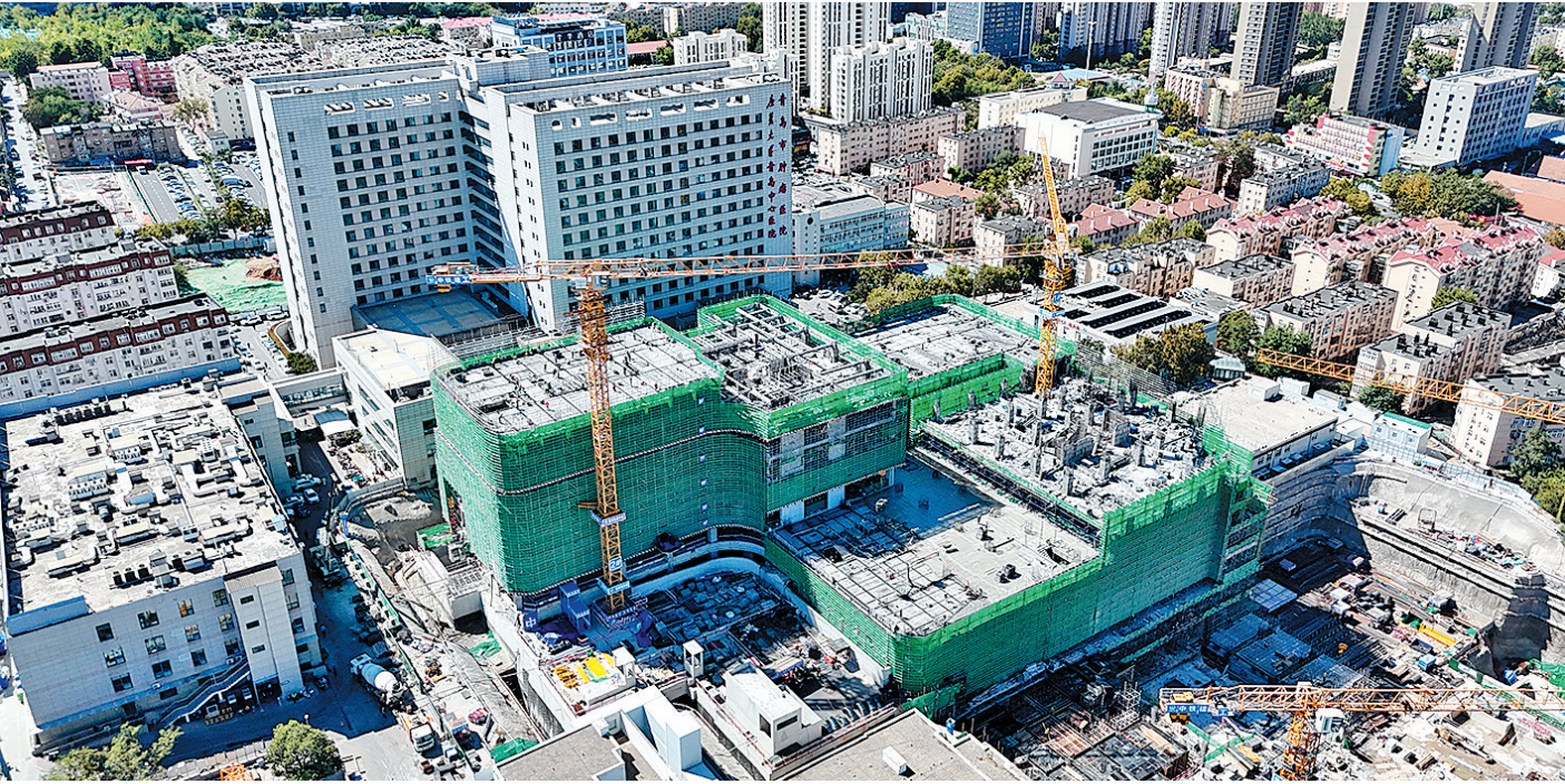
■康复大学青岛中心医院二期改扩建项目正朝着主体结构年底封目标稳步冲刺。
