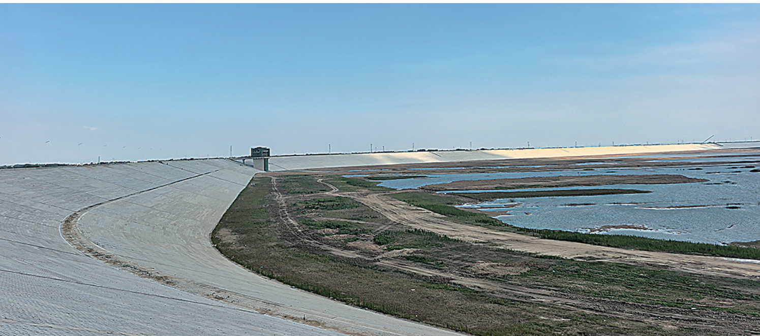
■官路水库围坝等主体工程全部完工,正为下闸蓄水做准备。 吴帅 摄
