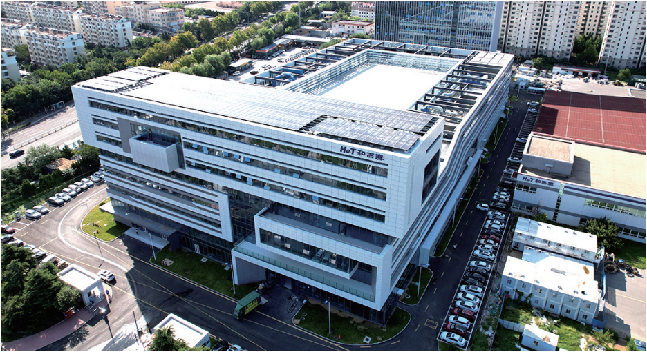
■和而泰青岛东北亚智能制造基地一期项目俯瞰。
