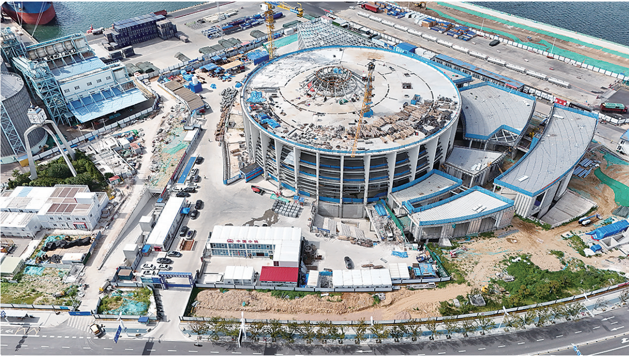
■青岛市图书馆新馆项目已进入主体结构施工收尾攻坚阶段。
