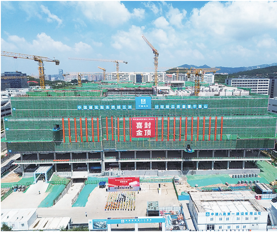
■虚拟现实整机二期项目计划2027年竣工投用。
