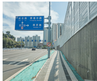
■人行道主体完工，并配建了挡土墙和隔音屏。
