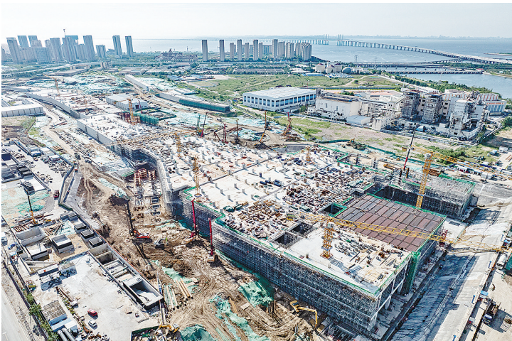
■借助数字建造技术,地铁5号线工程镇平路维保中心项目渐显雏形。 刘 栋 摄
