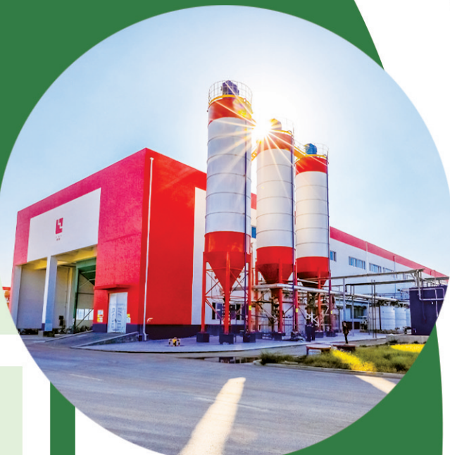
▲青岛洛唯新材料有限公司的现代化厂房。
