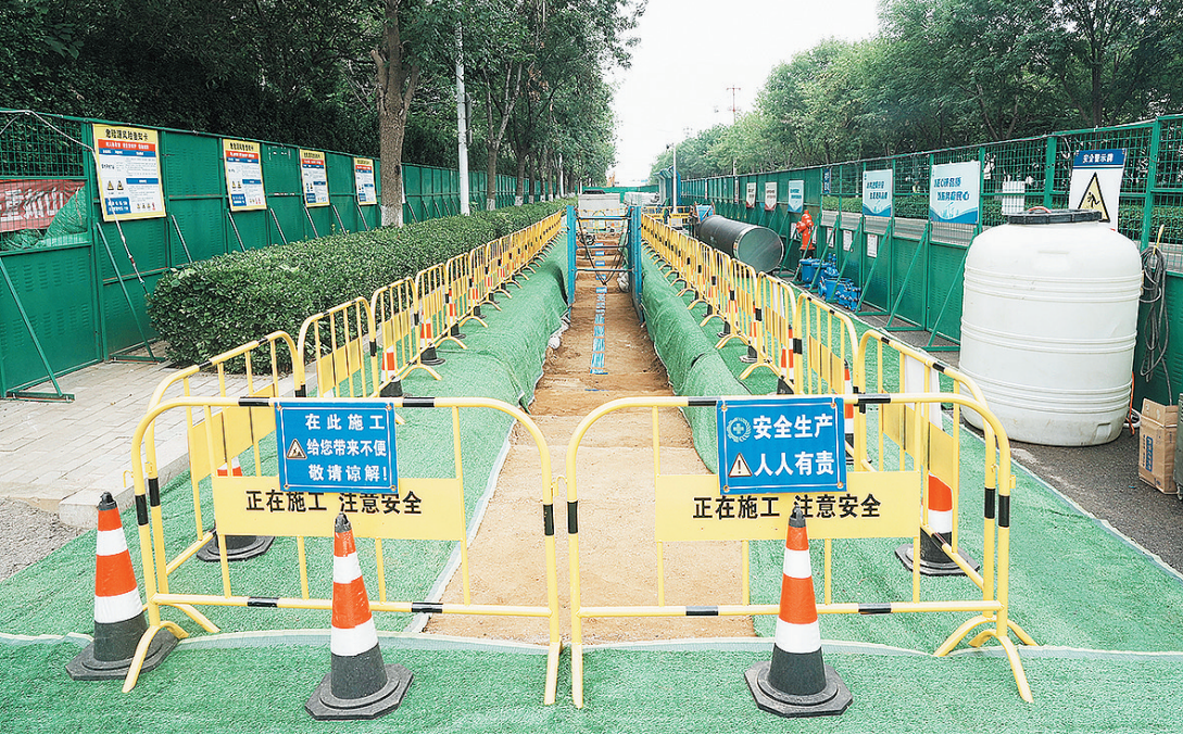
▲老旧供水管网改造施工现场。
