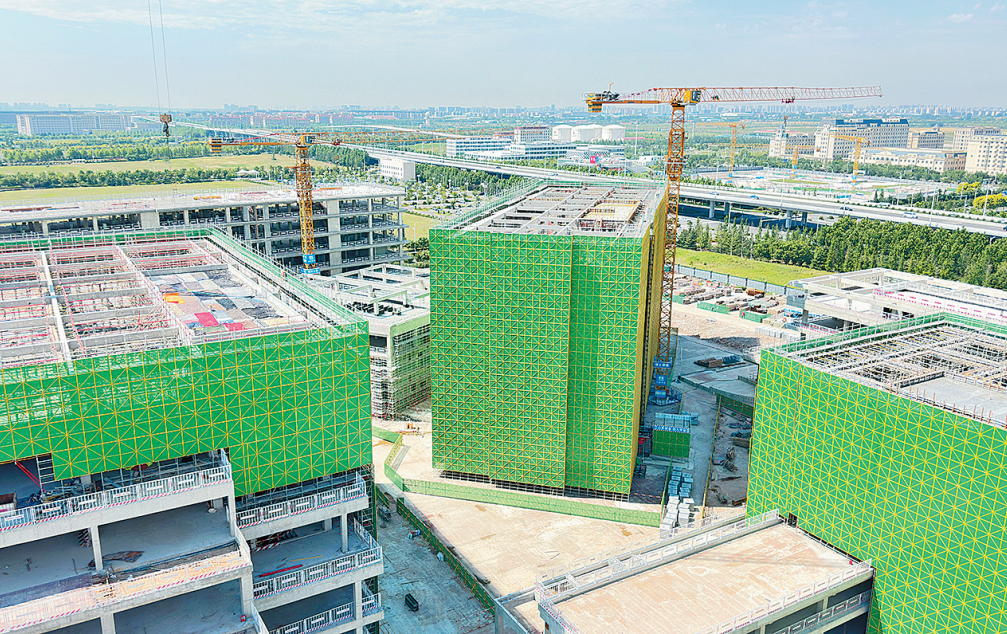
■位于临空经济示范区的青岛空港商务区项目建设现场。
