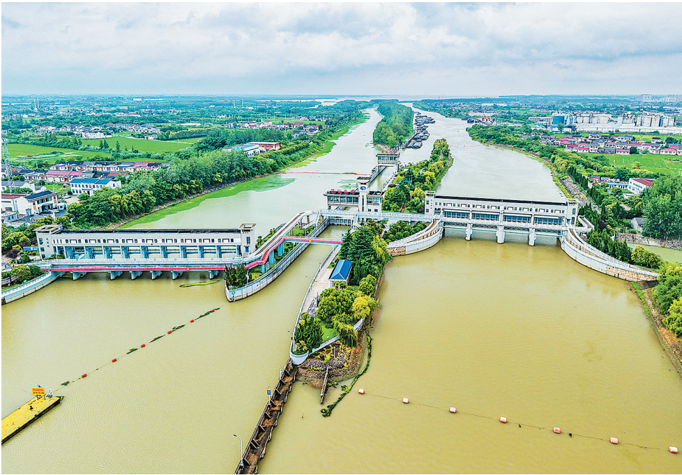
■8月11日拍摄的位于江苏省扬州市江都区的南水北调东线一期工程运盐闸、邵仙套闸、邵仙闸洞（无人机照片）。新华社记者片
