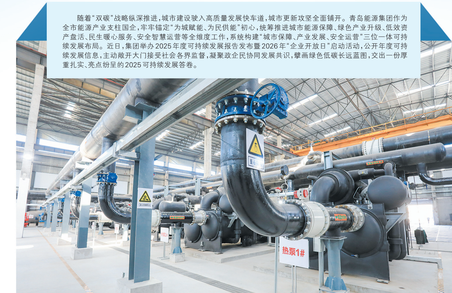
■李村河污水处理厂再生水能源综合利用项目。
