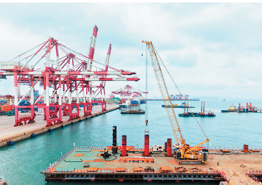
青岛港前湾港区北岸码头改扩建一期工程(72-74#泊位)钢管桩施工提前 7 天完成。
