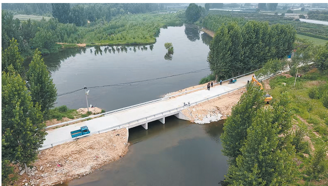
■平度市云山镇李家场东桥竣工通车，方便周边村民出行。
