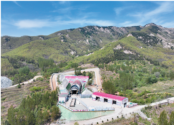
■近日,随着赵家林隧道顺利贯通,潍宿高铁至青岛连接线工程全线隧道全部贯通。
