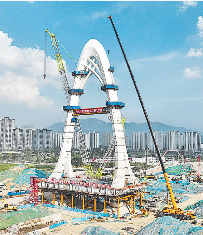
■被称为“青岛之窗”的科苑经七路桥主塔已封顶。邢志峰 摄
