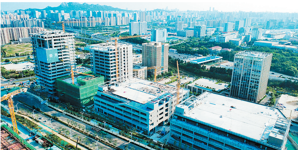
青岛虚拟现实产业园总部基地项目俯瞰。
