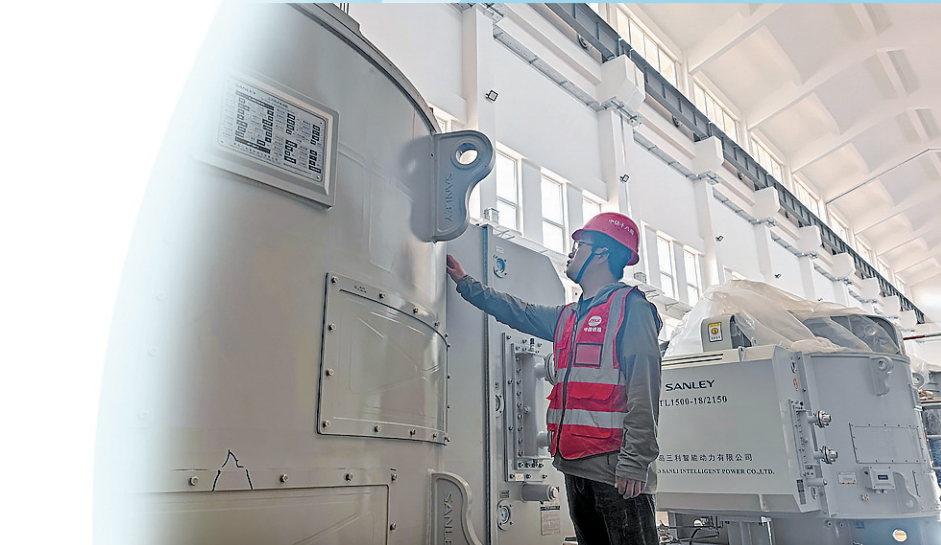
■工作人员调试水泵机组。
