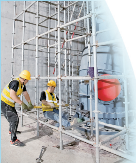
■工作人员安装混流泵。本版摄影 刘 栋
