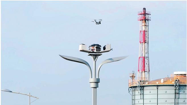
■无人机应用于青岛地铁高架线路巡检。
