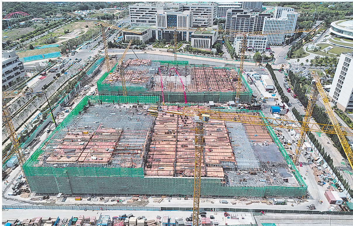
■崂山区歌尔虚拟现实整机二期项目正在加快建设。
