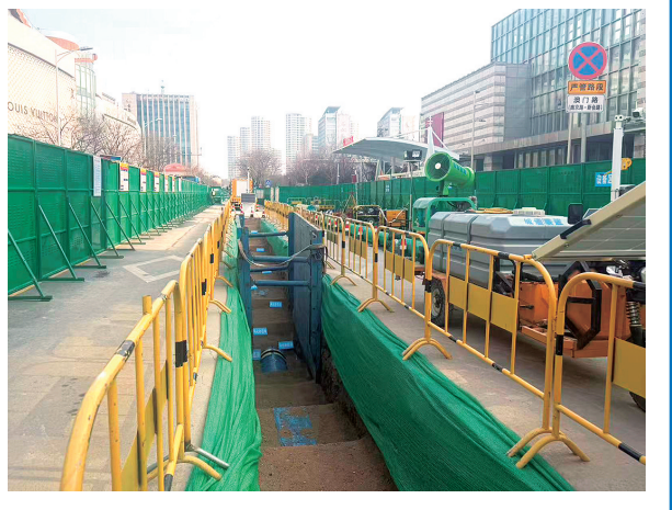
■供水管网改造现场设置有喷雾炮等降尘设备。吴帅 摄
