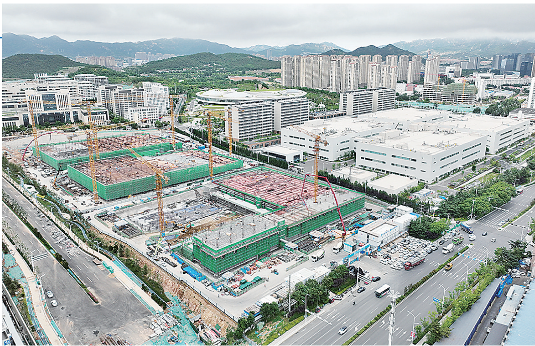
■歌尔虚拟现实整机二期项目建设现场。邢志峰 摄
