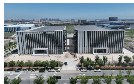
■高速滴灌管生产线项目已进入竣工收尾阶段。徐锋 摄
