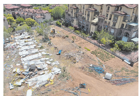
■城阳区山水嘉园小区西侧临时板房已拆除。
