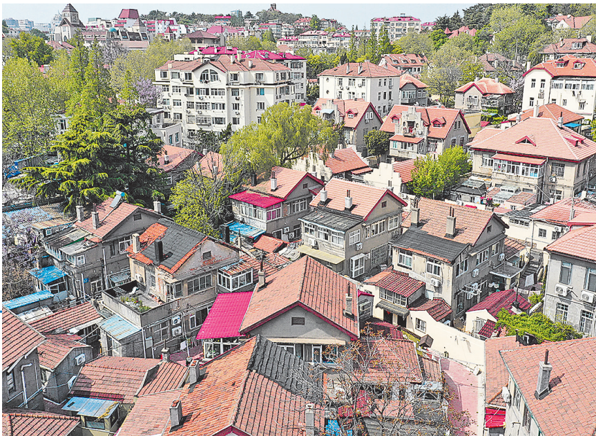
■张店路上多栋传统风貌建筑的屋顶被黑色卷材覆盖。
