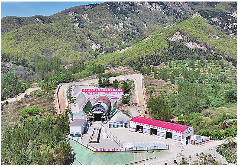
■4月30日,潍宿高铁至青岛连接线阳山隧道贯通。
