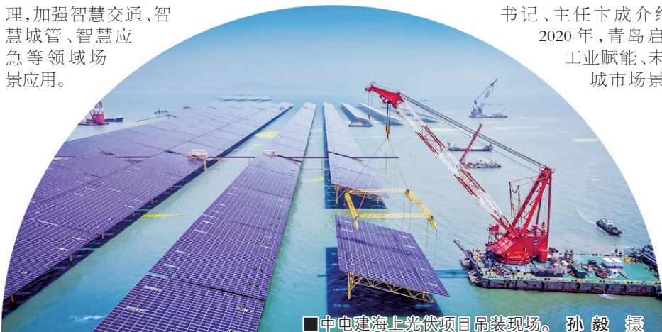
■中电建海上光伏项目吊装现场。孙毅摄
