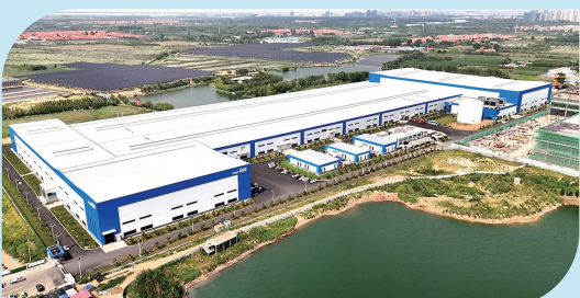
航拍鹏辉能源储能电池零碳制造基地。
